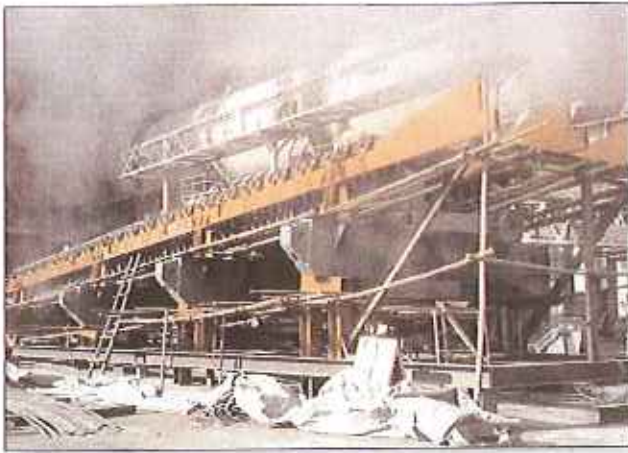
Figure 4: Installation of a pre-assembled grate cooler Bild 4: Einbau eines vormontierten Rostkühlers
